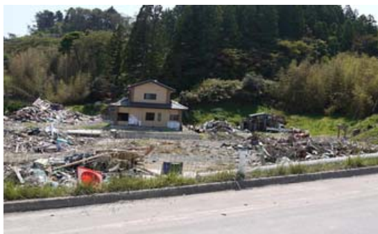
流されなかった住宅も使用不能
